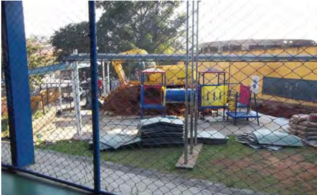
Figura 24. Reforma do parquinho visto da quadra
